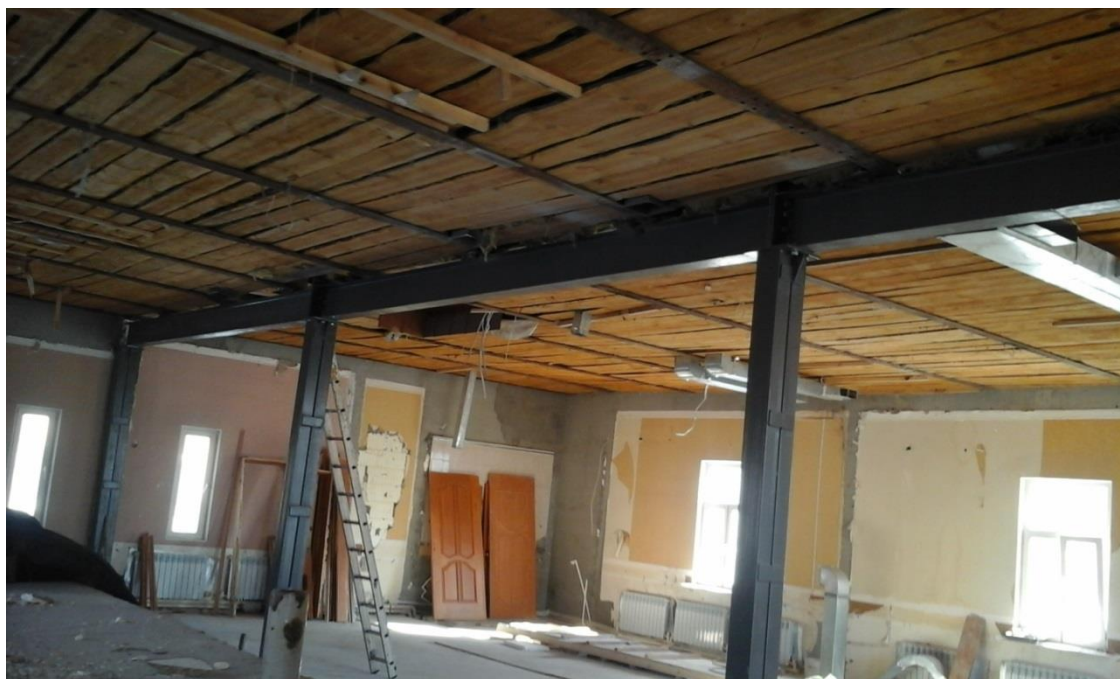
Рисунок 5 – Общий вид стальной рамы на втором этаже после демонтажа кирпичной стены
