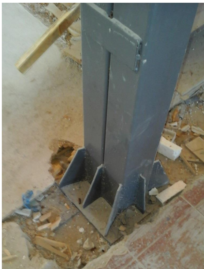
Рисунок 7 – База стальной стойки
