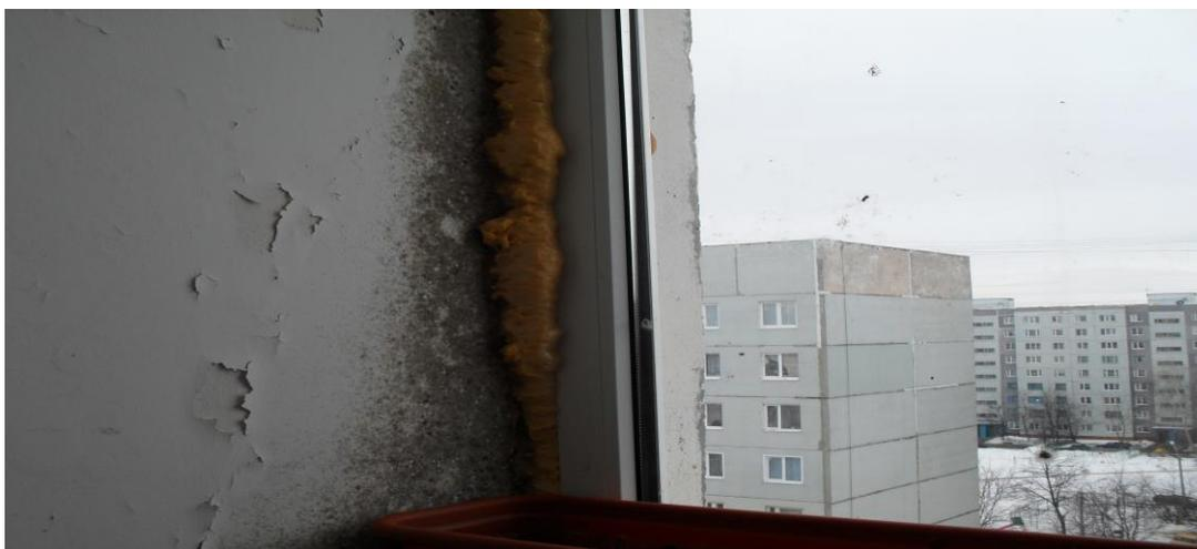
Рисунок 1 – Увлажненные участки наружных стен, отслоение отделочного покрытия и плесень на оконных откосах
