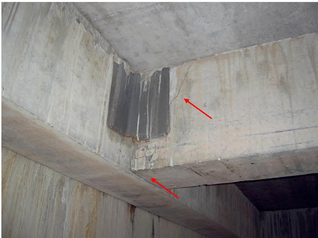
Рисунок 4 – Фрагмент перекрытия над подвалом. Трещины в пасынковом ригеле (в сопряжении с основным ригелем) шириной раскрытия до 5,0 мм
