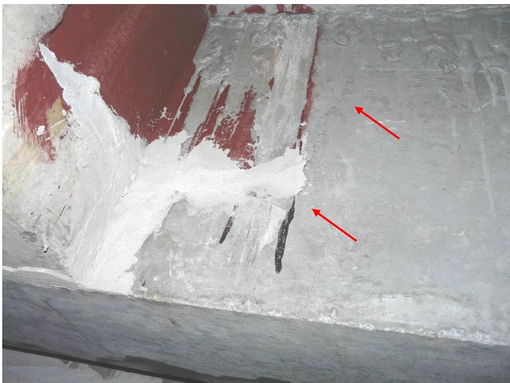
Рисунок 5 – Фрагмент ригелей перекрытия над вторым этажом. Трещина вдоль закладной детали крепления пасынок ригеля
