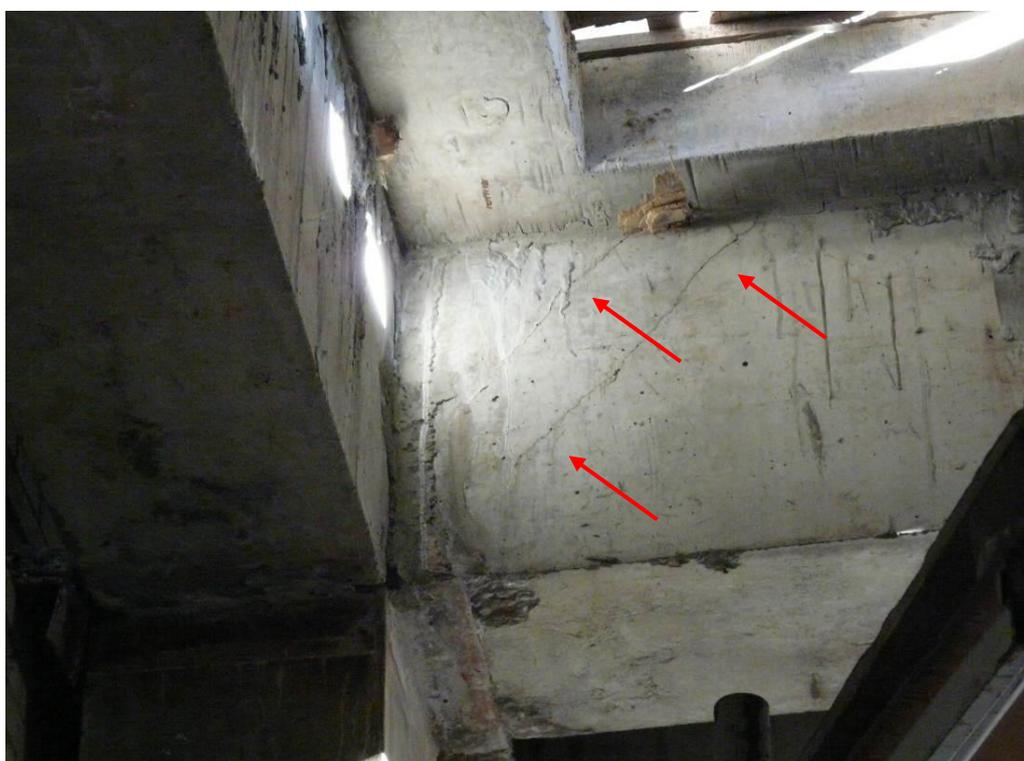
Рисунок 3 – Фрагмент перекрытия над вторым этаж. Трещины в основном ригеле в месте сопряжения с колонной шириной раскрытия до 2 мм
