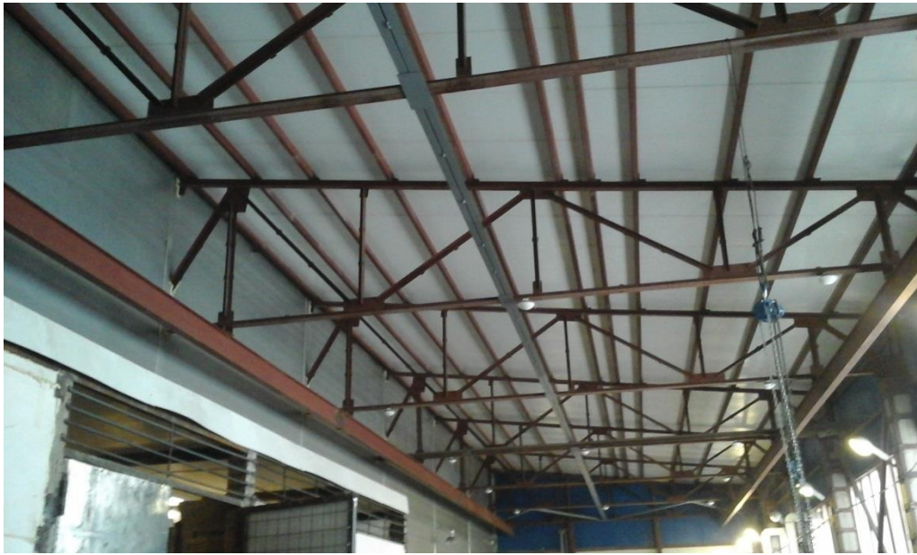
Рисунок 3 – Стропильная ферма с кран-балкой в пролёте нового здания
