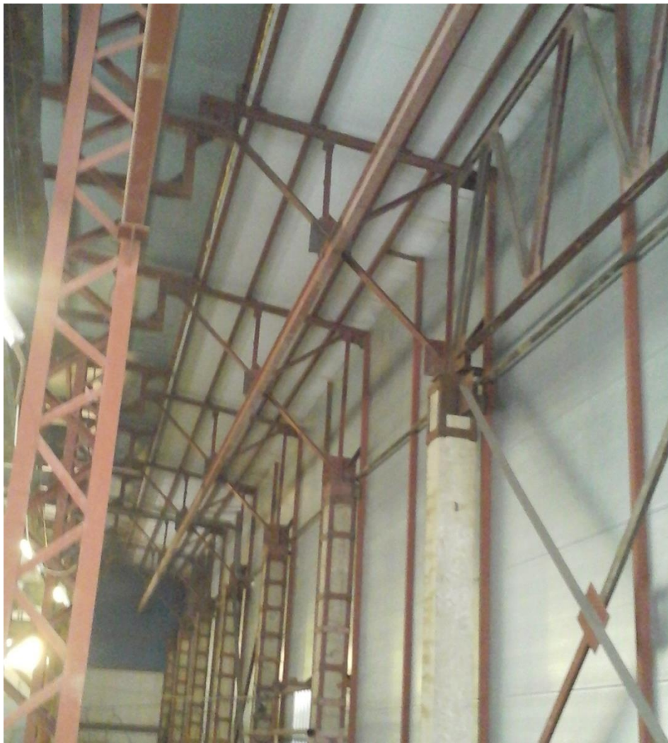
Рисунок 4 – Консоль с монорельсом в пролёте между зданиями
