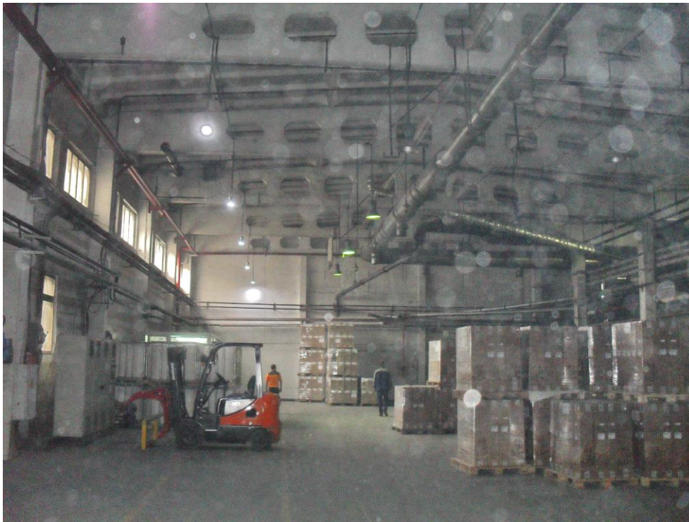
Рисунок 2 – Фрагмент здания до монтажа кранового оборудования
