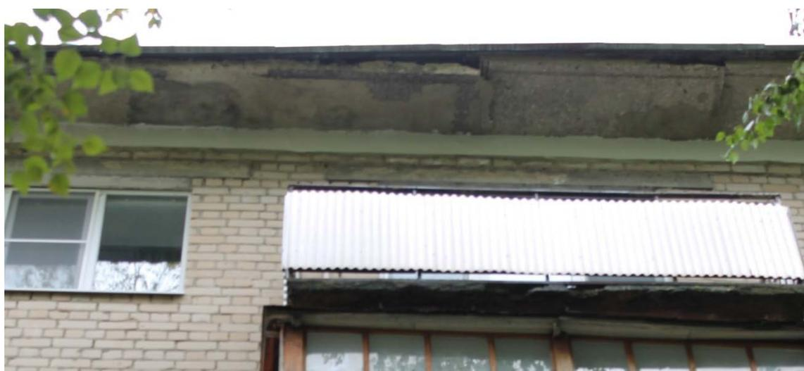
Рисунок 1 – Крен железобетонных карнизных плит
