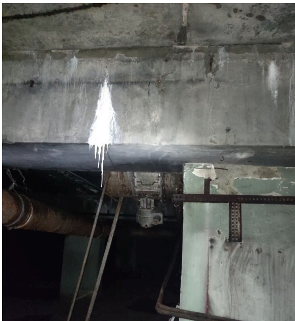
Рисунок 1 - Трещина в несущей балке
