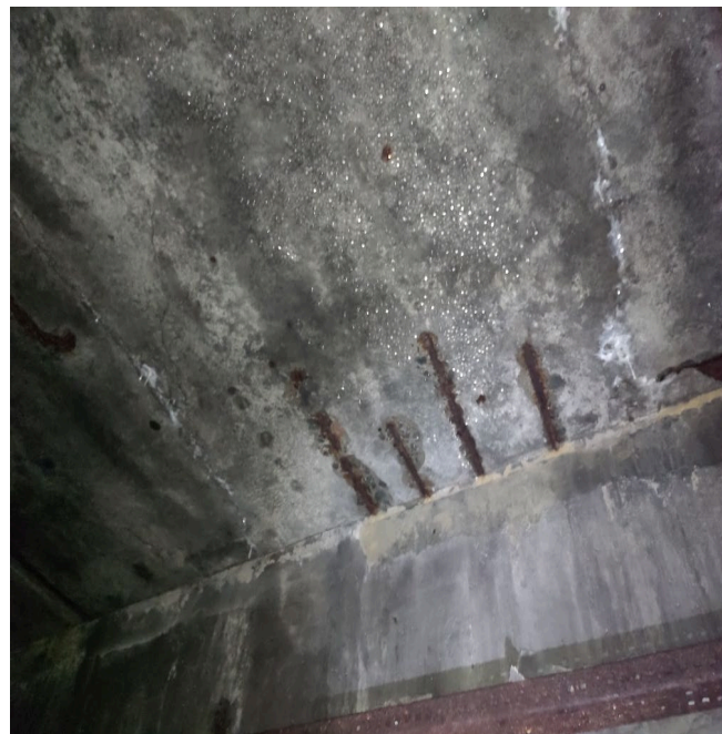
Рисунок 1 - Трещина в несущей балке
