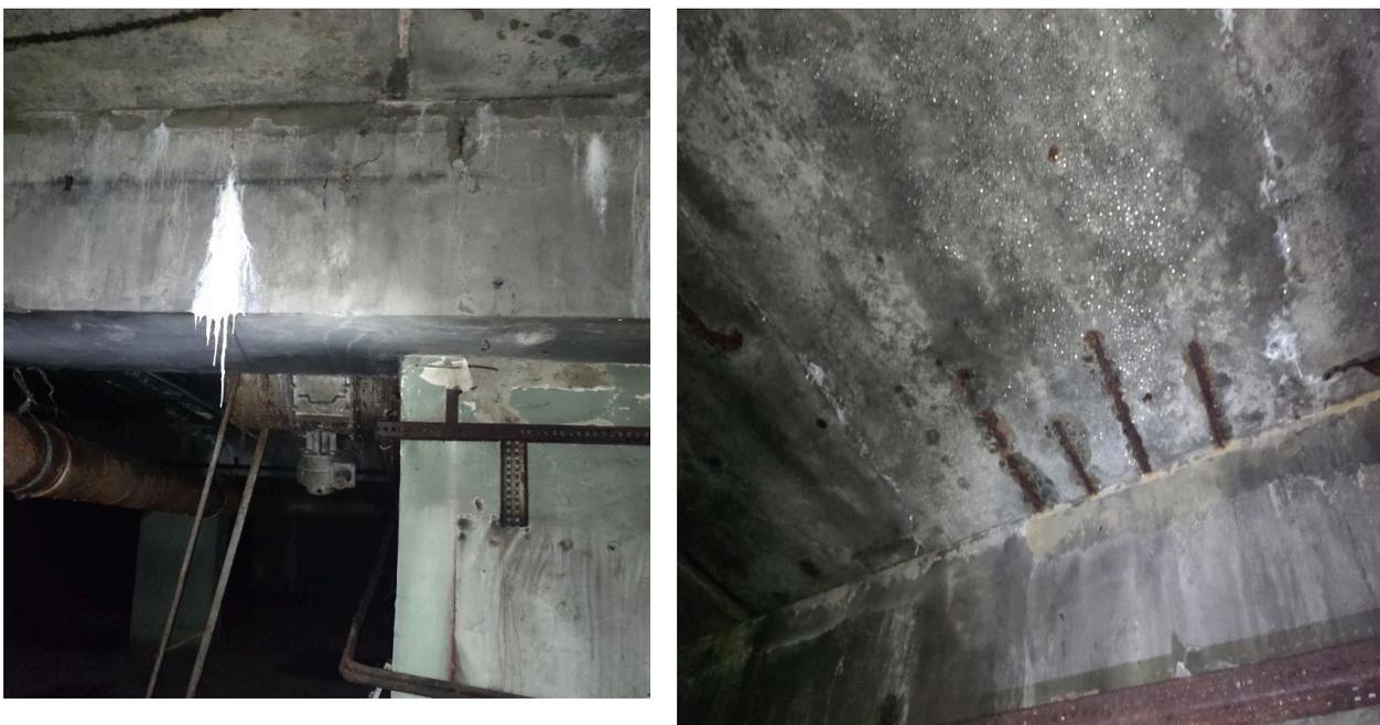
Рисунок 1 - Трещина в несущей балке
