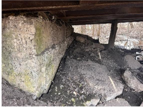
Рисунок 3. Конструкция берегового устоя мостового перехода
