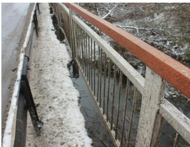
Рисунок 1 – Пролет 2 Тротуар справа. Разрушение бетона, нарушение анкеровки перил, коррозия металлических элементов (ржавление)
