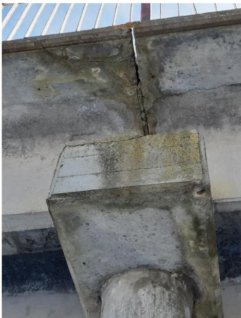
Рисунок 3 – Намокание крайних балок пролетного строения, ригеля, опоры
