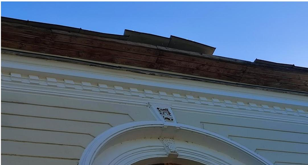
Рисунок 3 – Загнивание карнизов здания
