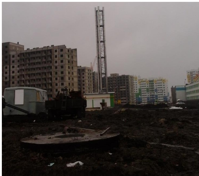
Рисунок 5 – Фермовая мачта из секций башенного крана
