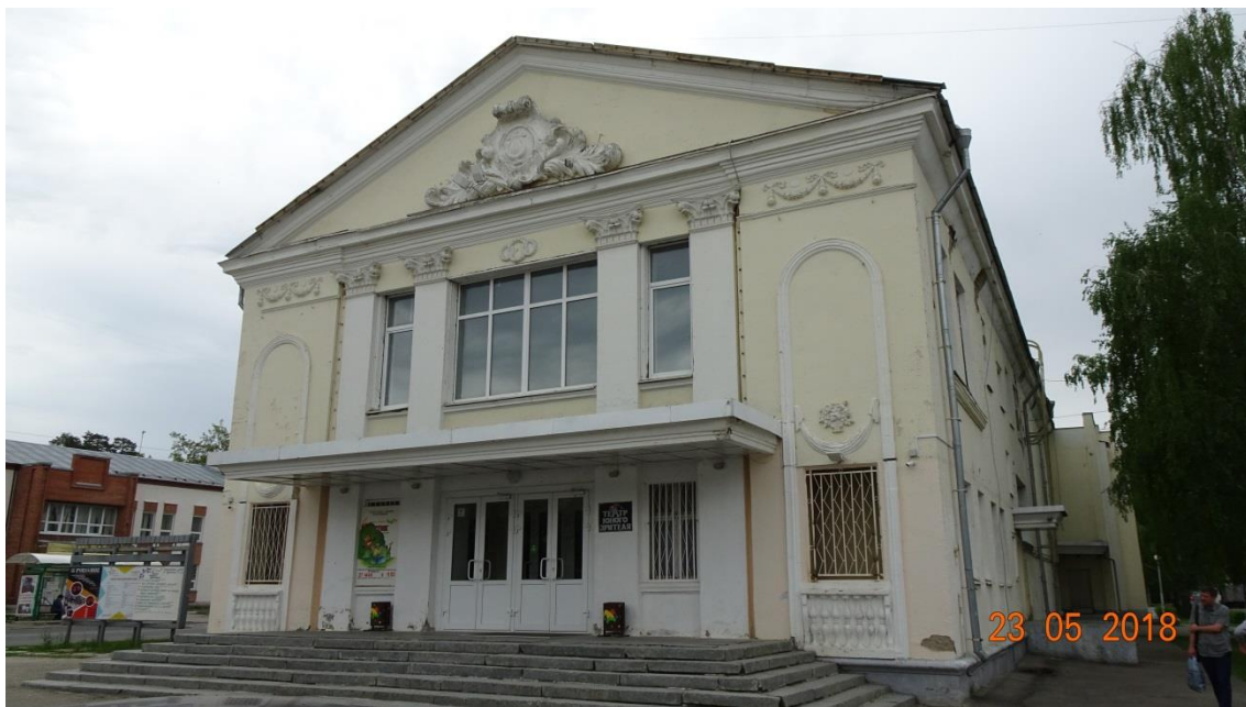
Рисунок 1 – Общий вид здания ТЮЗ
