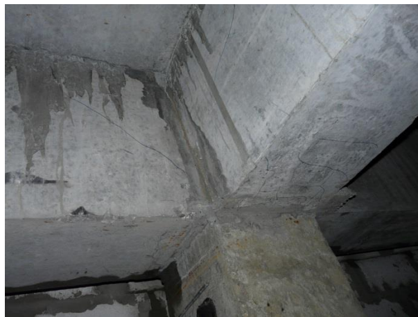
Рисунок 2 – Разрушения и повреждения несущих конструкций перекрытия при строительстве здания торгового центра в г. Пензе а, б – разрушение узлов сопряжений ригелей перекрытия с колоннами; в, г - трещины в ригеле шириной раскрытия до 2,0 мм
