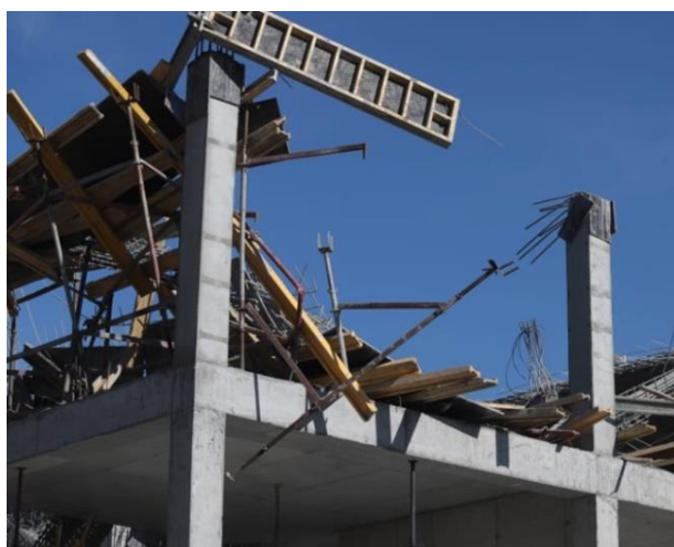
Рисунок 1 – Примеры обрушения несущих конструкций перекрытия монолитных каркасных зданий
