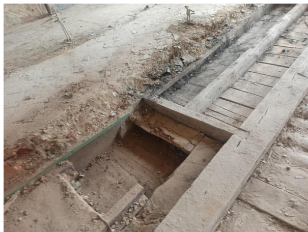
Рисунок 1 – Состояние перекрытий
