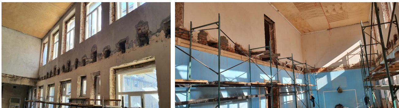
Рисунок 2 – Помещения здания после демонтажа перекрытий
