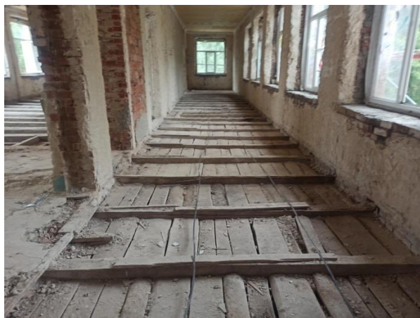
Рисунок 1 – Состояние перекрытий
