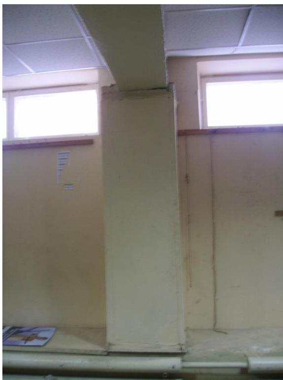
Рисунок 4 – Смещение оси ригеля от разбивочных осей на 120мм.
