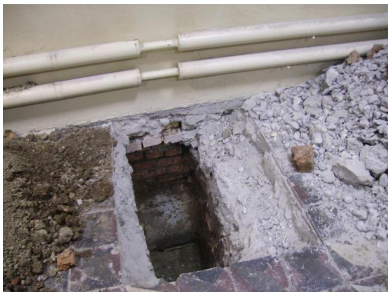
Рисунок 3– Превышение ширины фундаментных балок на 180 мм.
