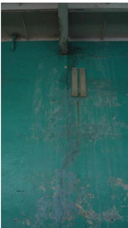
Рисунок 3 - Вид изнутри стены спортзала в месте сопряжения со смежным объёмом. Сквозная трещина на всю высоту стены; интенсивное замачивание стены и опорной части стропильной балки
