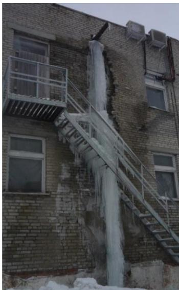
Рисунок 1 - Непроектный наружный водоотвод с низким качеством изготовления. Замачивание и разрушение кирпичной кладки в стене на глубину 120 мм; разрушение опоры под перемычкой
