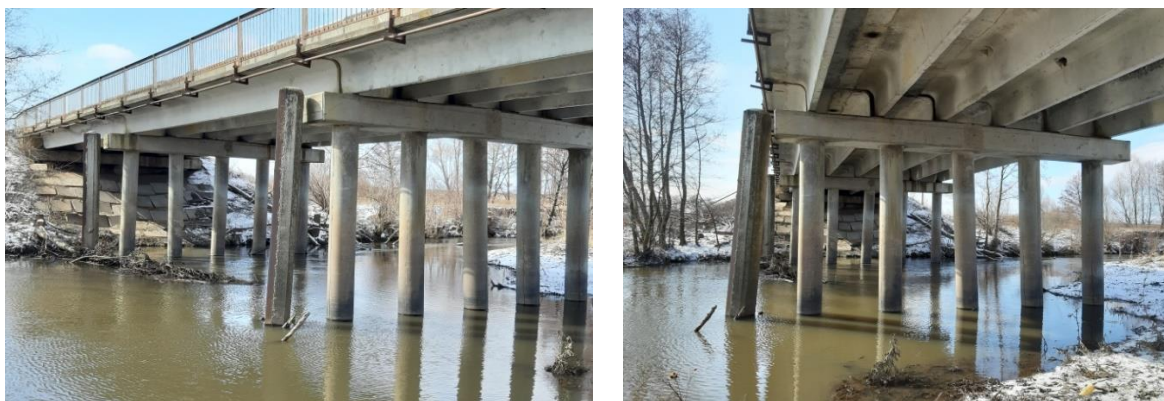
Рисунок 3 – Ледорезная свая перед однорядными промежуточными опорами
