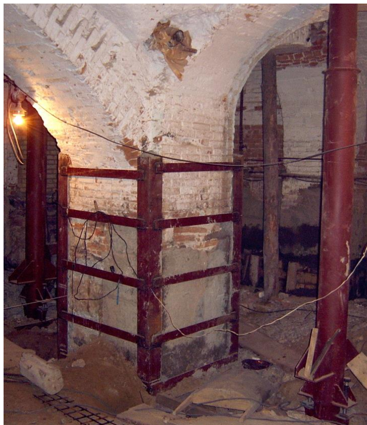
Рисунок 3 – Временные стальные стойки силовой подъемной системы
