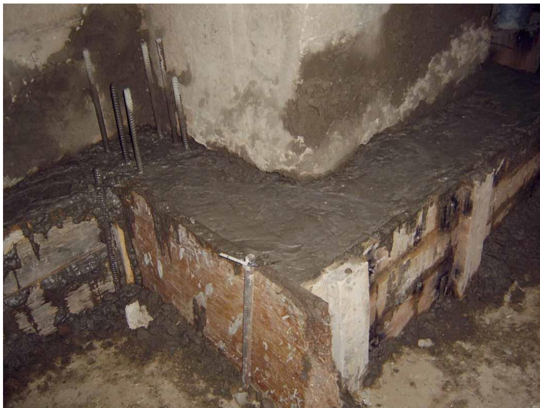
Рисунок 4 – Монолитный ростверк усиления фундаментов
