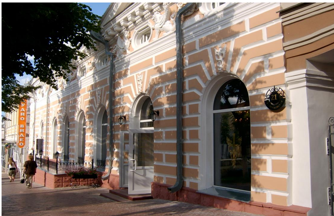
Рисунок 1 – Общий вид здания со стороны ул. Московской
