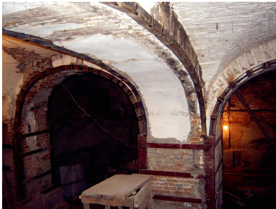
Рисунок 6 – Общий вид усиления стальными обоймами поврежденных арок подвального перекрытия и опорных столбов сводов
