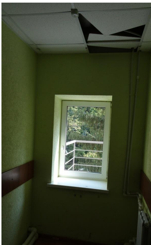
Рисунок 4 – Вид изнутри места устройства проема в стене на втором этаже
