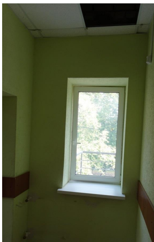
Рисунок 2 – Вид изнутри места устройства проема в стене на втором этаже
