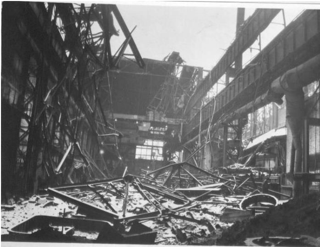
Рисунок 1- Последствия обрушения плит покрытия (1988 г, Пенза)
