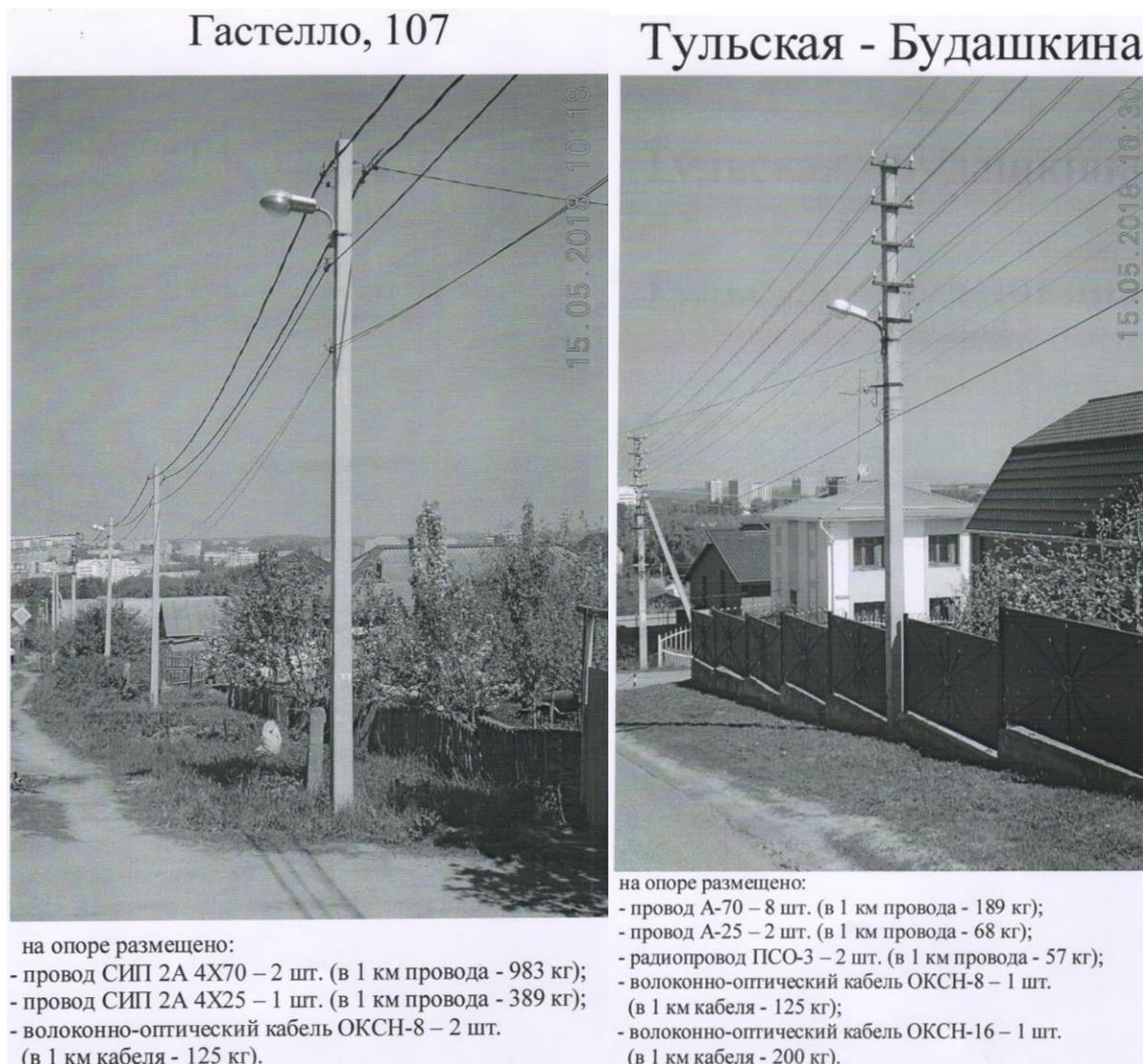
Рисунок 1 - Опоры линий электропередач
