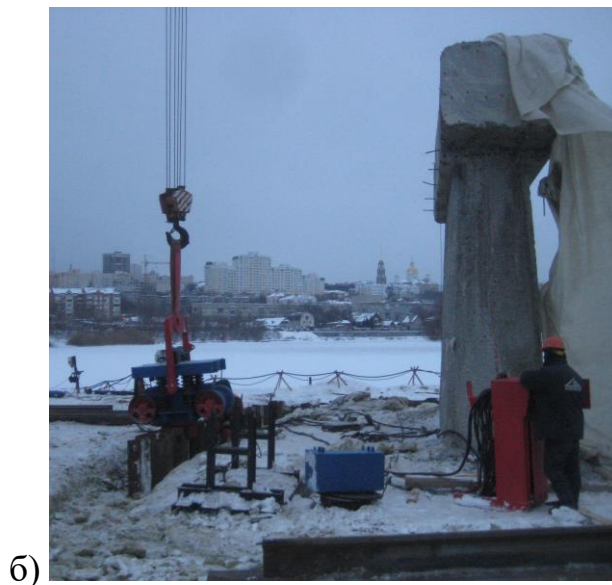
Рисунок 2 – Устройство шпунтового ограждения. Мост через реку Сура: а – установка шпунта, б - вибропогружение
