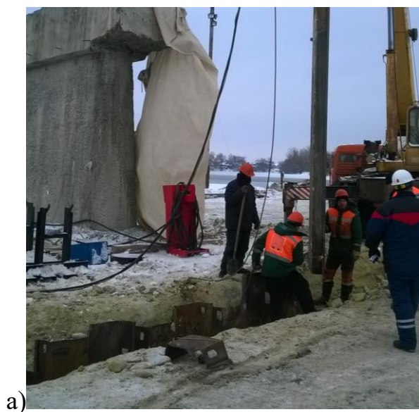
Рисунок 2 – Устройство шпунтового ограждения. Мост через реку Сура: а – установка шпунта, б - вибропогружение
