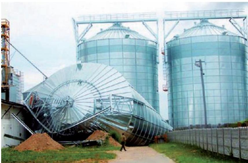
Рисунок 2 – Пример обрушения металлического силоса
