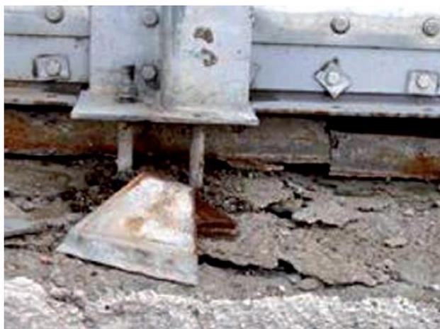
Рисунок 3 – Пример разрушения стыка металлических панелей и фундамента
