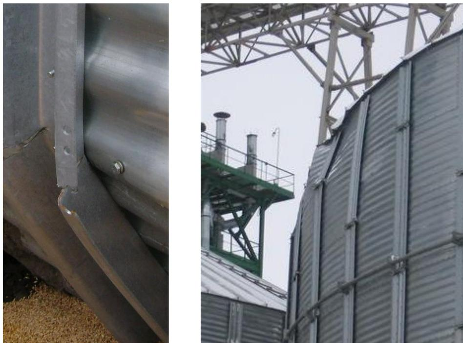
Рисунок 4 – Примеры повреждения вертикальной стойки и металлических панелей силоса
