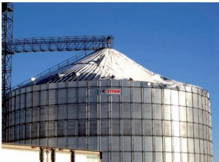
Рисунок 5 – Пример обрушения крыши силоса в результате превышения допустимой снеговой нагрузки
