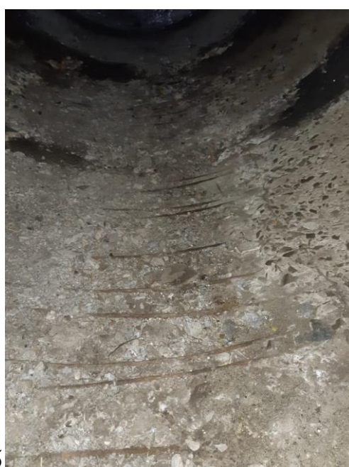
Рисунок 2 – Разрушение стыков труб (а), разрушение защитного слоя бетона, обнажение арматуры (б)
