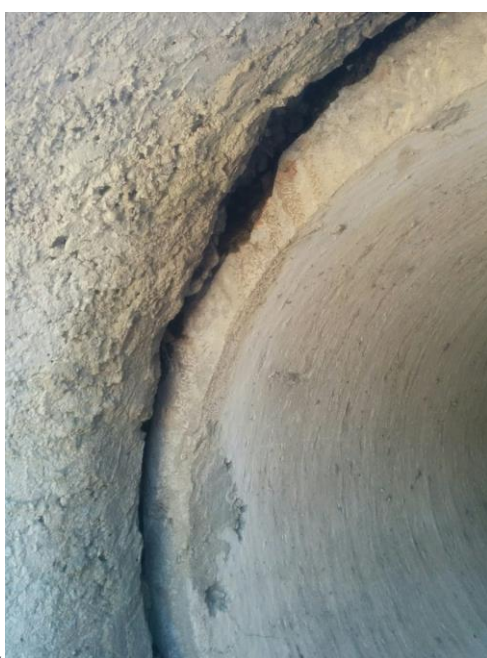
Рисунок 2 – Разрушение стыков труб (а), разрушение защитного слоя бетона, обнажение арматуры (б)
