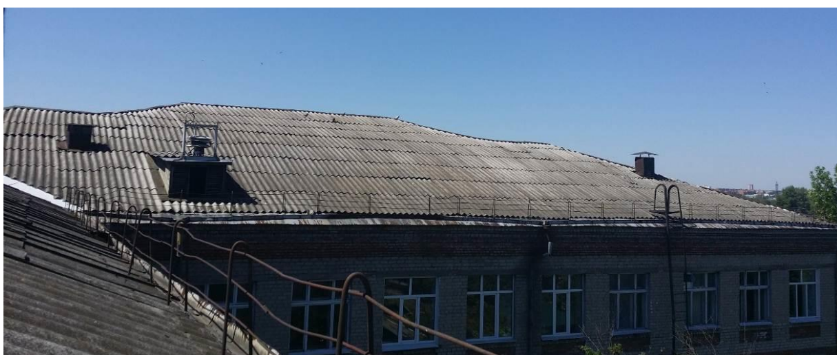
Рисунки 1, 2 – Общий вид крыши здания МБОУ СОШ №40 г. Пензы
