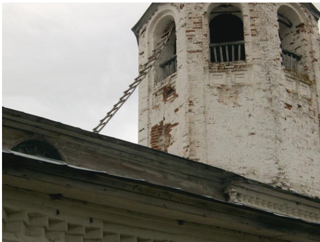
Рисунок 2 - Повреждения наружных стен
