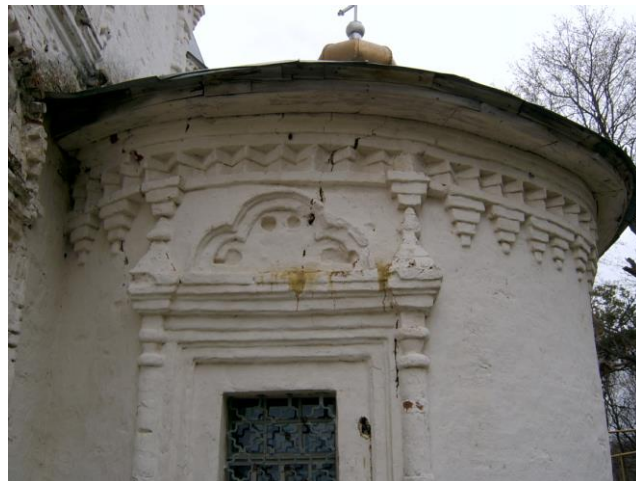
Рисунок 2 - Повреждения наружных стен
