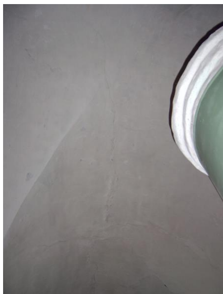
Рисунок 3. Повреждения свода помещения малого иконостаса в осях 1-3/А-Г а – план помещения с трещинами на потолочной поверхности свода; б, в – трещины на потолочной поверхности свода в осях 1-2/В-Г и 2-3/А-Б (соответственно)
