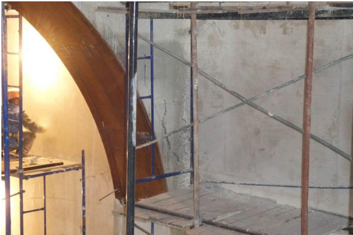
Рисунок 1 - Трещина шириной раскрытия до 30 мм
