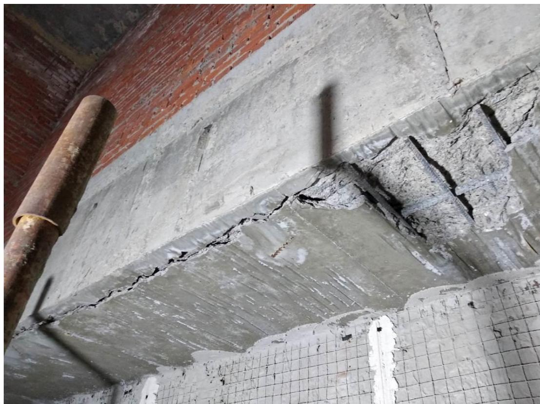
Рисунок 2 - Ослоение защитного бетонного слоя с обнажением арматуры
