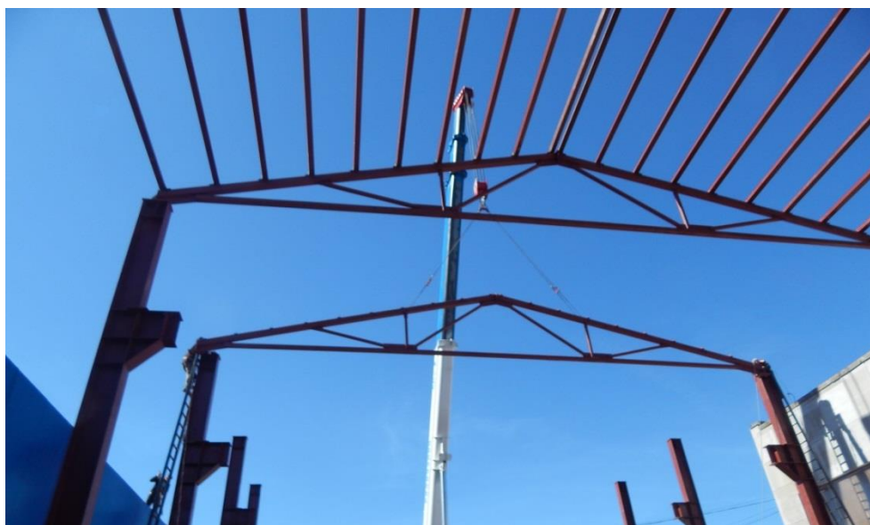
Рисунок 5 - Фермы в проектном положении
