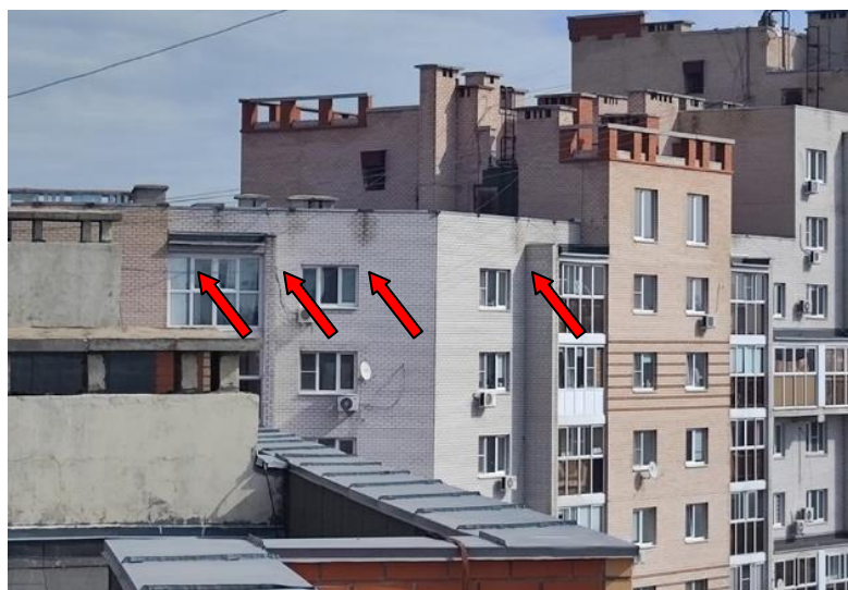
Рисунок 2 – Замачивание кирпичной кладки
