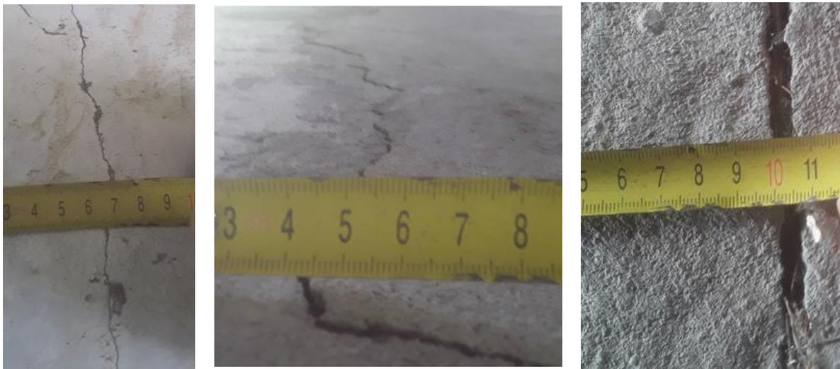
Рисунок 2 – Виды и размеры трещин в опорах моста
