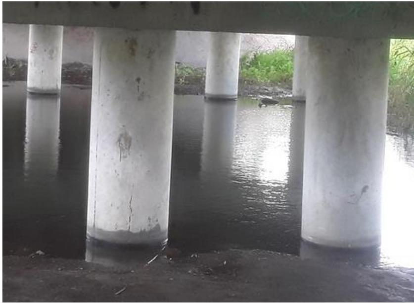
Рисунок 1 – Опоры-оболочки (трещины)
