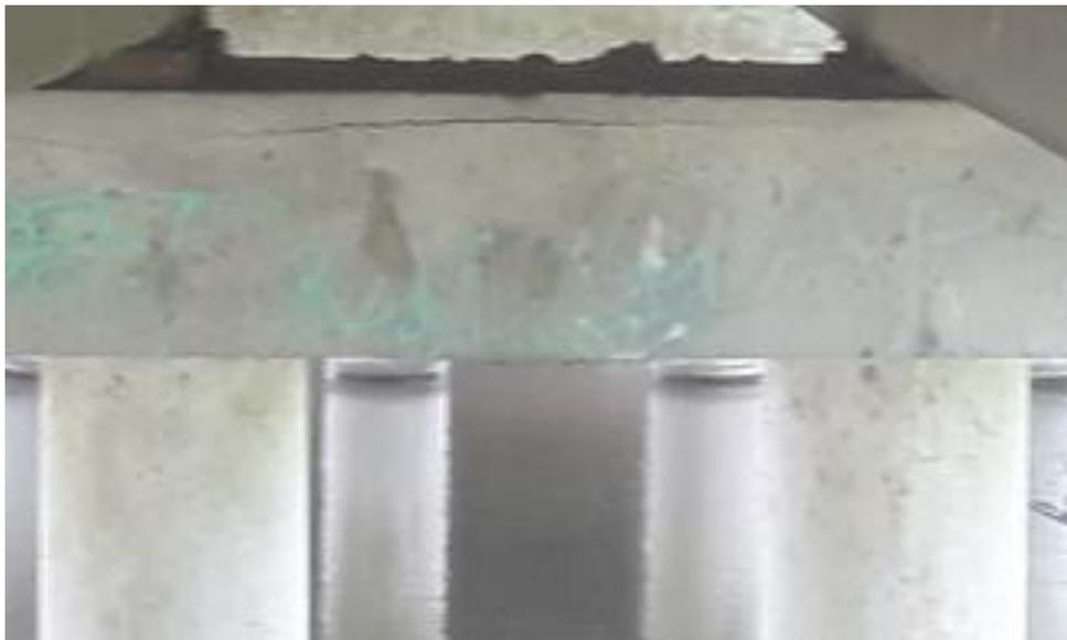
Рисунок 3 - Продольные трещины в сжатой зоне железобетонного ригеля
