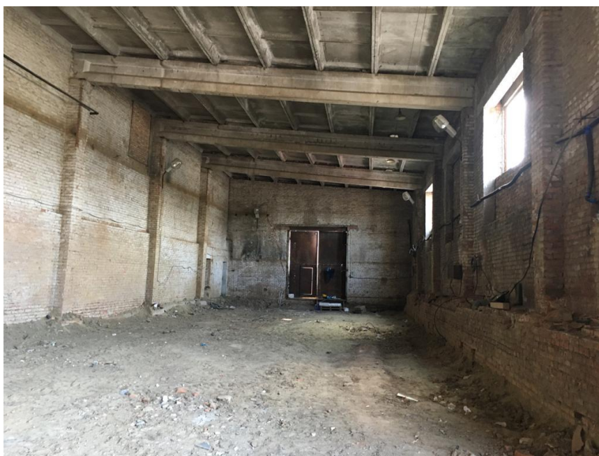
Рисунок 2 - Общий вид пролёта изнутри здания
