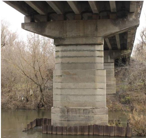
Рисунок 3 – Промежуточная опора. Следы протечек по ригелю
