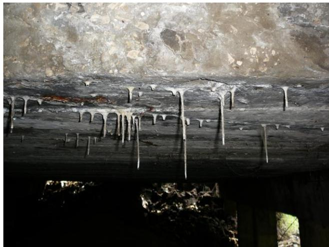
Рисунок 4 – Нарушение гидроизоляции. Выщелачивание бетона
