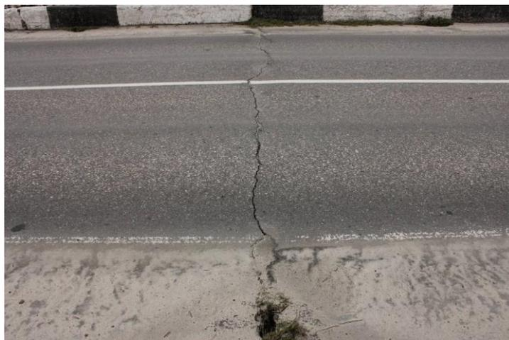
Рисунок 2 – Состояние деформационного шва на опоре
