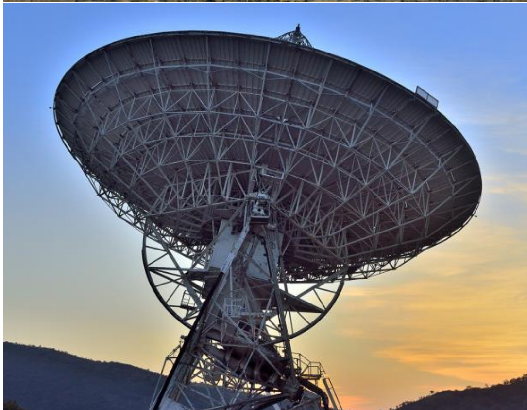
Рис. 1. Виды рабочей поверхности и несущей системы локатора
